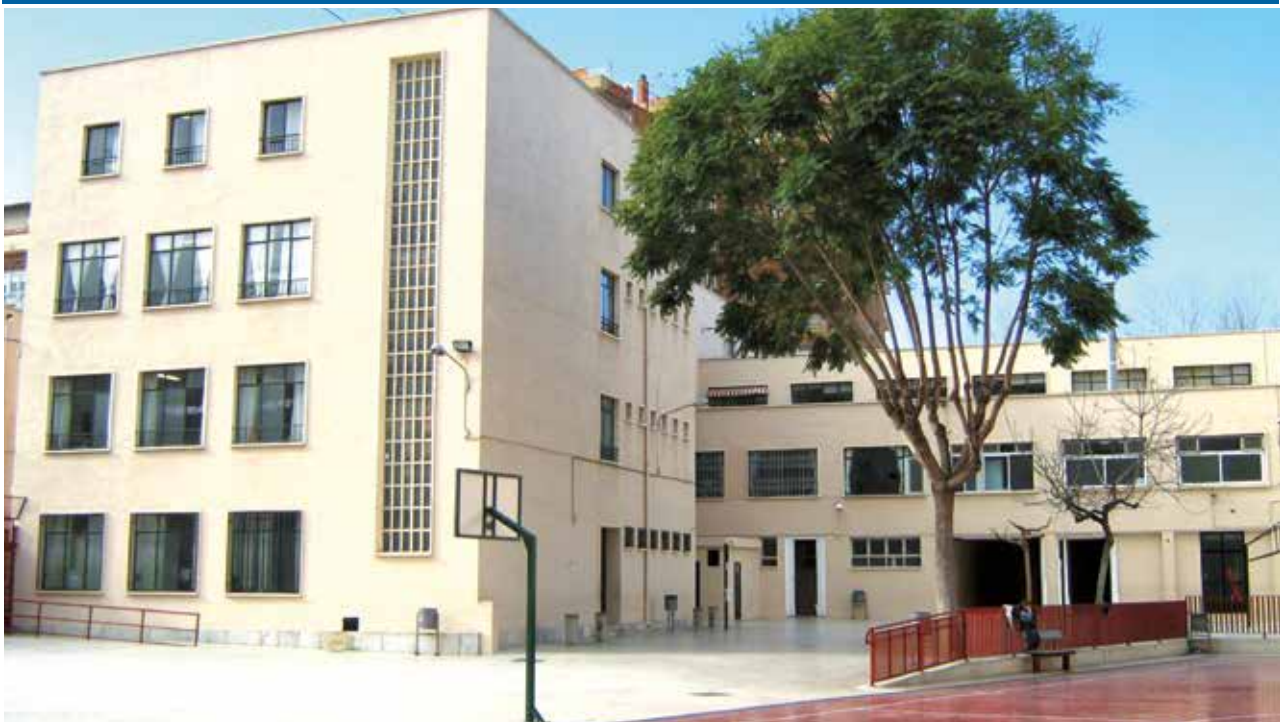
Lieu : Murcie Équipements installés : Suite Multisystème
