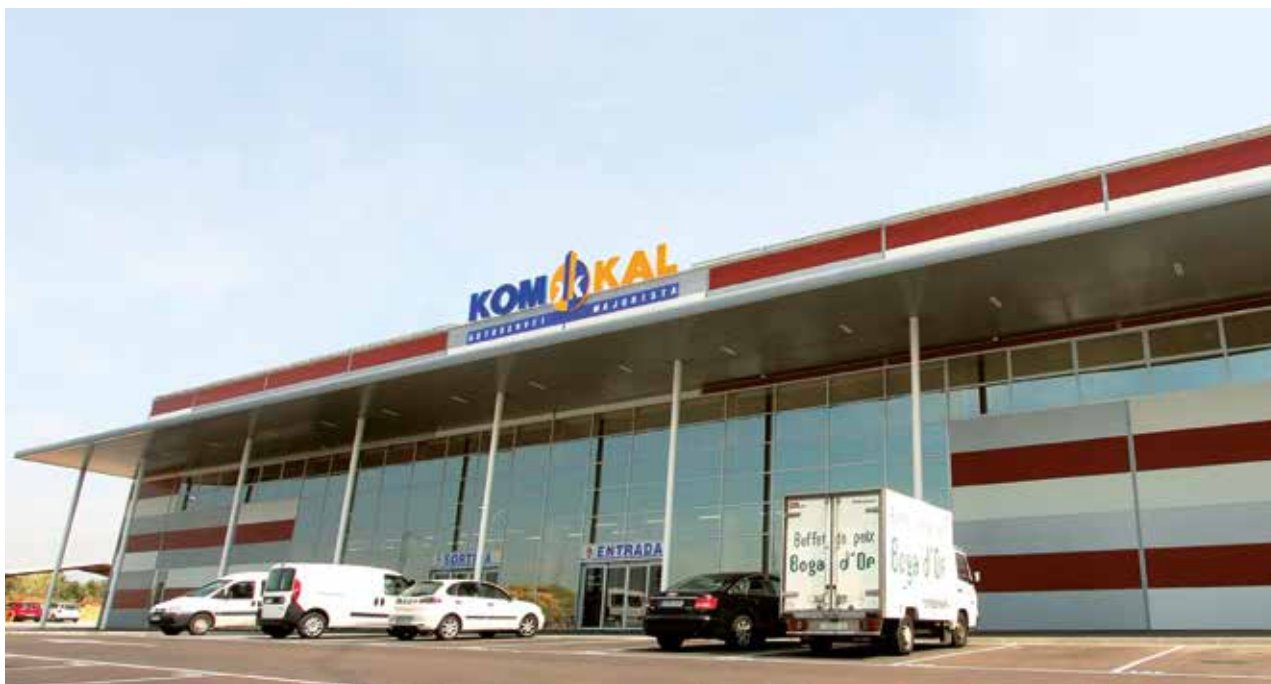
Lieu : Reus (Tarragone) Équipements installés : MODBUS
