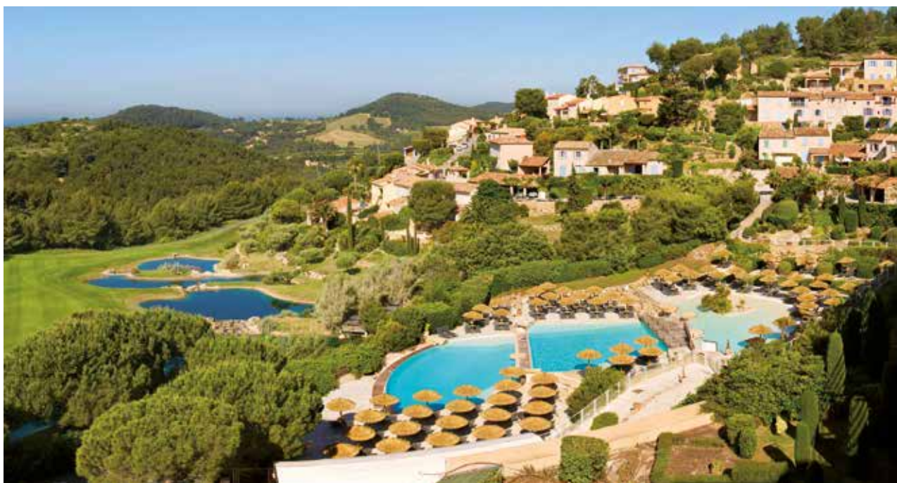
Lieu : Provence (France) Équipements installés : KAYNET
